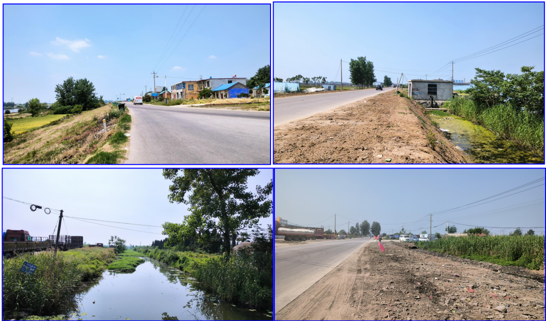
图 3-4 路基路面排水工程现状
